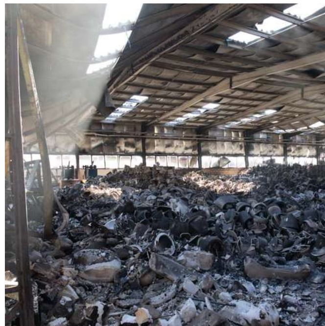
Imagem 3: Escombros do incêndio na Sanindusa 2, em 2017
